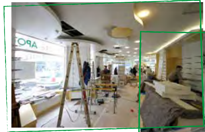
Der komplette Umbau der Apotheke bei laufendem Betrieb 2010.
